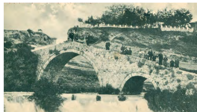
Η γέφυρα του Χατζηκάβουρα ή του Σταυρού.
