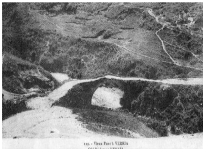
Η μονότοξη γέφυρα του επαρχιακού δρόμου Βέροιας-Ξελίου.
