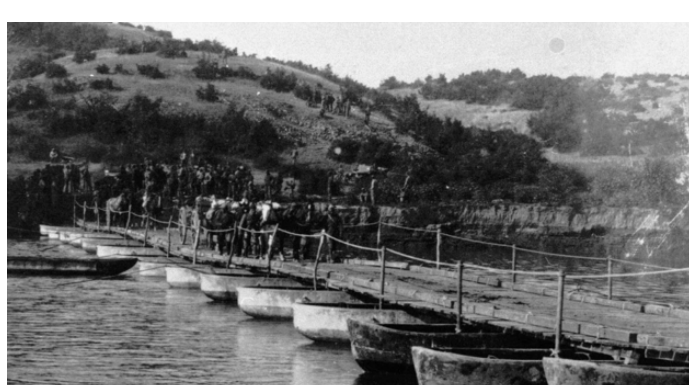
Λεμβόζευκτες γέφυρες έτοιμες για τη διάβαση του Έβρου ποταμού
