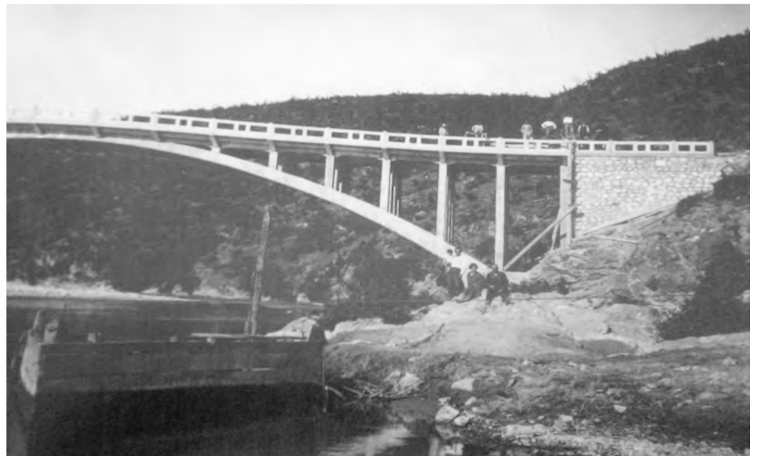
Το «πέλημα» της γέφυρας στην όχθη του Βερμίου, απομεινάρια του οποίου διασώζονται ως σήμερα. Η ξύλινη κατασκευή σε πρώτο πλάνο, το εναέριο βαγόνι παροπλισμένο πλέον... (Συλλογή Θεοδωρίδη Αδάμ)
