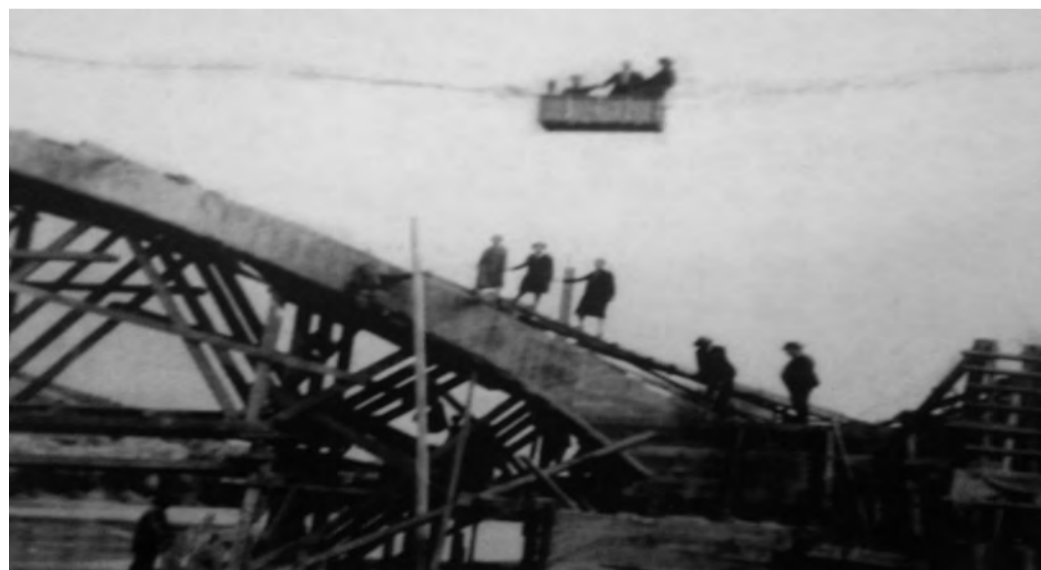
Οι προκαταρκτικές εργασίες υποστυλώσεως για την κατασκευή της γέφυρας. Παρατηρήστε το βοηθητικό εναέριο βαγόνι!!! (Συλλογή Θεοδωρίδη Αδάμ)
