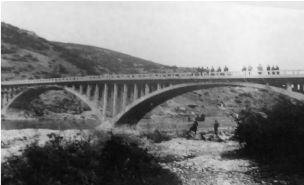
Το αθάνατον έργον, η γέφυρα Κοκκόβης που έσωσε τα περατιανά χωριά και από την οποία θα περάσει η νέα οδός προς Κόκκοβαν-Βόσσοβαν και Ριζώματα (Αστήρ Βερροίας Αρ.Φ. 262/149 - 23 Οκτωβρίου 1933).
