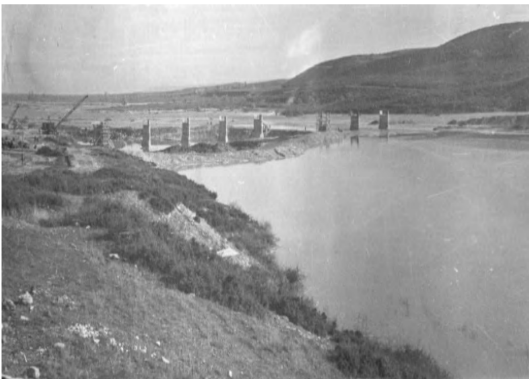
Οι εργασίες θεμελίωσης του φράγματος μετά από εκτροπή του ποταμού Αλιάκμονα
