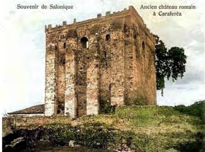
Ο αποκαλούμενος «Πύργος της Βεργίνας» πριν την κατεδάφισή του
