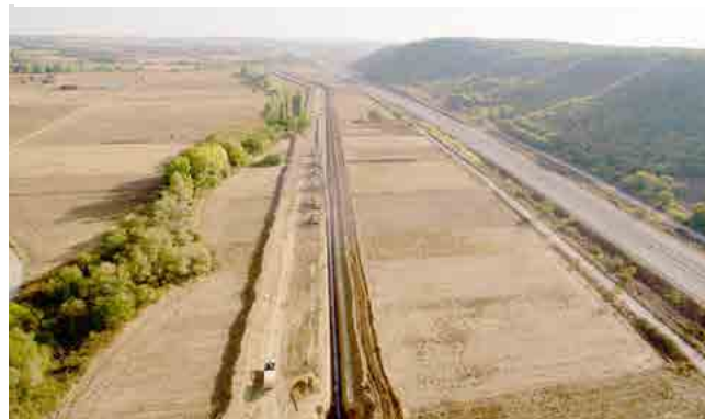
Καταβίβαση συγκολλημένου τμήματος αγωγού, Βόρεια Ελλάδα, Νοέμβριος 2016
