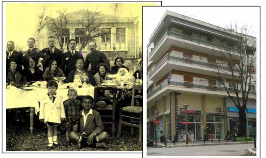
Σήμερα στην ίδια θέση, η γωνιακή οικοδομή επί της συμβολής των οδών Ανοίξεως & Πίνδου 30.
